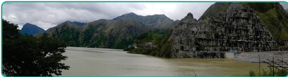
Figura 4. Represa Chixoy: Su embalse se encuentra dentro del territorio del Municipio de Rabinal, que entro otros efectos, causó la separación e incomunicación de algunas aldeas de Rabinal con su cabecera municipal, fragmentando así algunas familias y desconfigurado de esa manera sus actividades socio económicas y culturales desde 1980, de lo cual hasta en fechas recientes se está reconociendo por parte del gobierno los hechos y efectos a través de acciones de resarcimiento, derivado de los acuerdos de paz, suscritos después del enfrentamiento armado interno.
